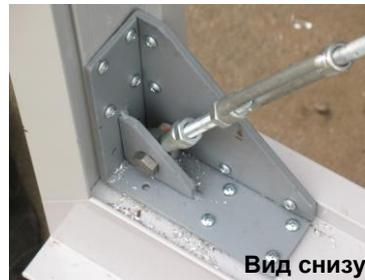
3. Сверление и стяжка конструкции
